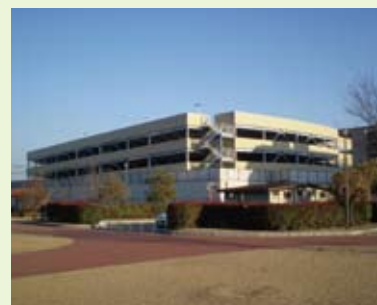
当社がめっきした JA尾道総合病院立体駐車場
