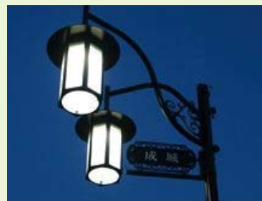
東京・世田谷区成城の街を照らす街路灯
