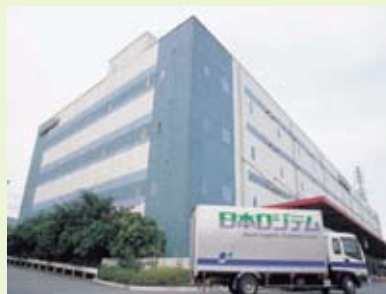
関東・中部・関西・四国・九州に拠点
