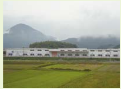
青垣町の工場・倉庫全景
