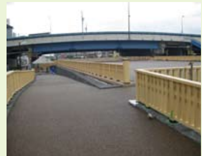
東京・江戸川区の橋高欄施工実績
