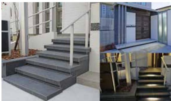
「ケコミ」を使用した浮遊感のある屋外階段。写真右下は、LED照明を取り付けた施工例
