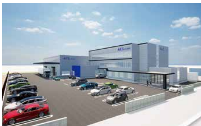
2025年4月から稼働予定の新本社工場（大分市廻栖野）
