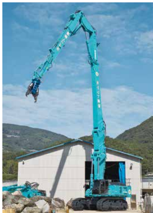
大型重機により約40mの高所でも解体作業が可能
