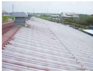
施工例：工場の屋根 遮熱塗装前
