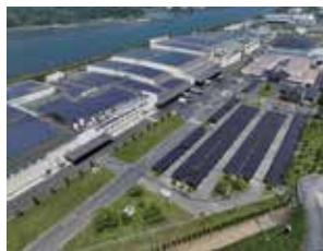
導入事例：社屋の屋根上とカーポートに 設置された太陽光発電設備 (アリアケジャパン(株))
